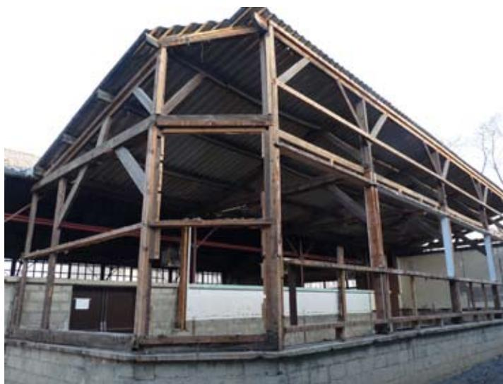
La salle polyvalente (ancienne salle des fêtes) en cours de démontage. En régie, nos employés communaux ont commencé la démolition. L'intervention, d'une entreprise spécialisée pour enlever les plaques d'amiante en toiture, est prévue afin que les autres corps de métiers puissent démarrer.
