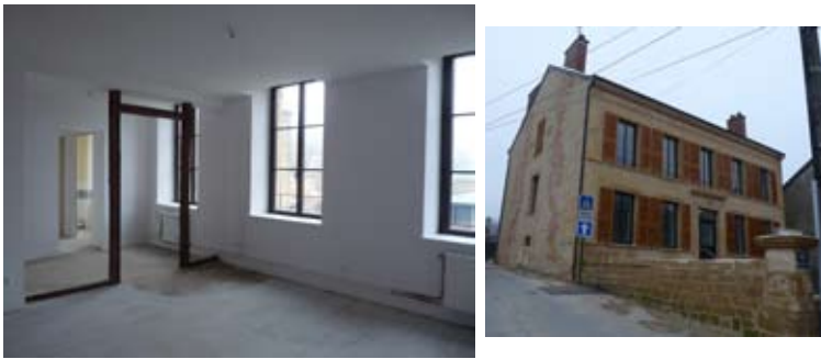
La restructuration de l'ancien presbytère
