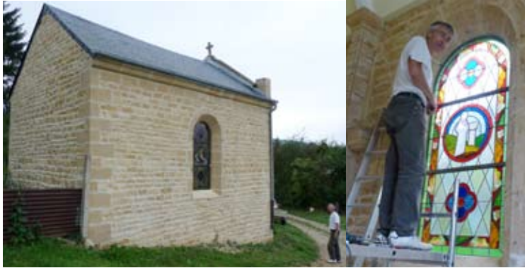
A la chapelle St Walfroy, la pose des vitraux par le maître verrier Philippe Filion est en cours. Après quelques petits aménagements, nous pourrions célébrer l'inauguration de la restauration complète.
