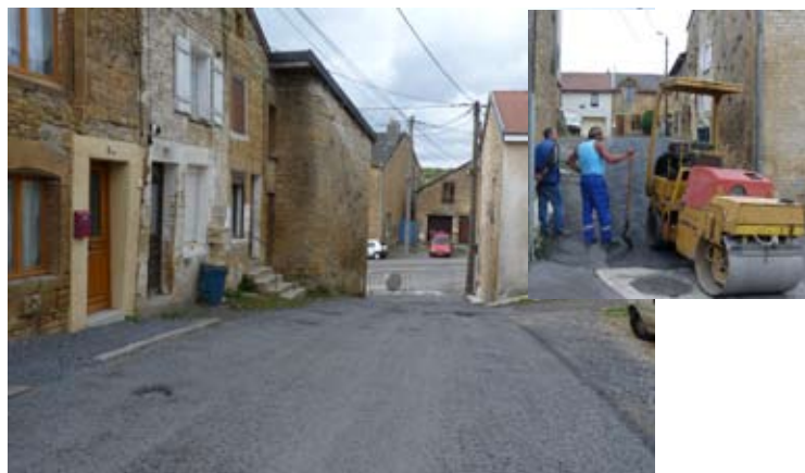
La détérioration importante des rues du Culot et de Montcornet a justifié la réfection du revêtement de la chaussée.
