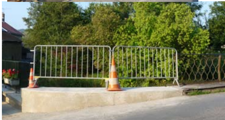
En attendant la pose d'une nouvelle balustrade aux normes de sécurité, fabriquée par AEL, nos employés communaux coulent le tablier en béton.
