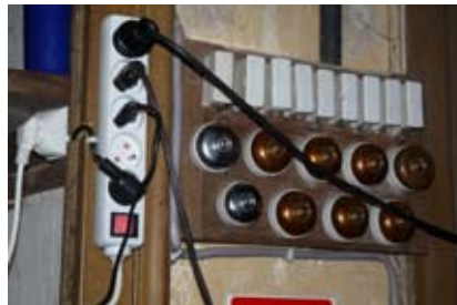
La protection électrique ne correspond plus aux exigences de sécurité actuelle
