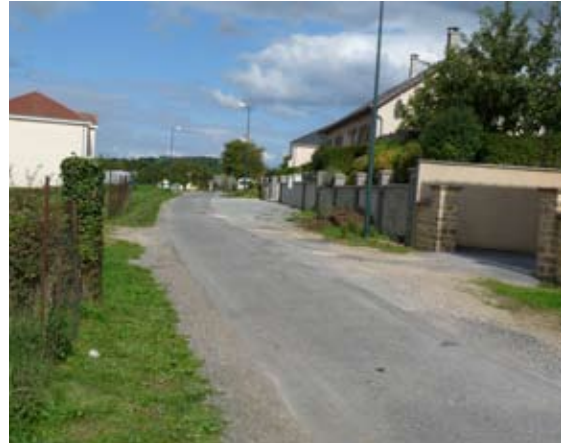
la voirie, l'évacuation des eaux pluviales et l'attente de l'assainissement de la voie de Donchery
