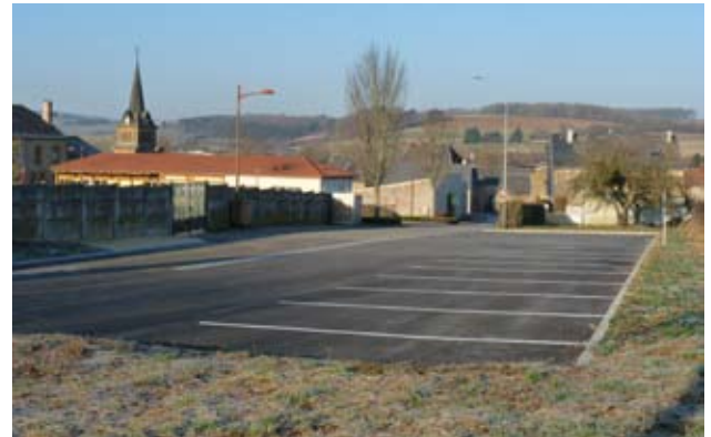
Le parking du cimetière est en fonction depuis le mois d'octobre, s'il est peu utilisé à certaines heures il remplit ses services aux heures de rentrées et de sorties du pôle scolaire et du multi-accueil.
