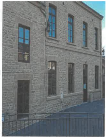
Restauration des façades de la mairie
